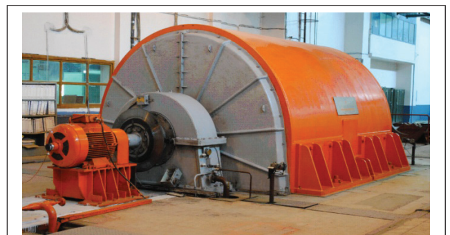
FIG. 20 MOTOR-LESS SC GENERATOR
